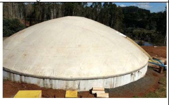
L - Biodigester Alemão ou CSRT (Continuous Stirred Tank Reactor – Tanque Reator de Agitação Contínua)
