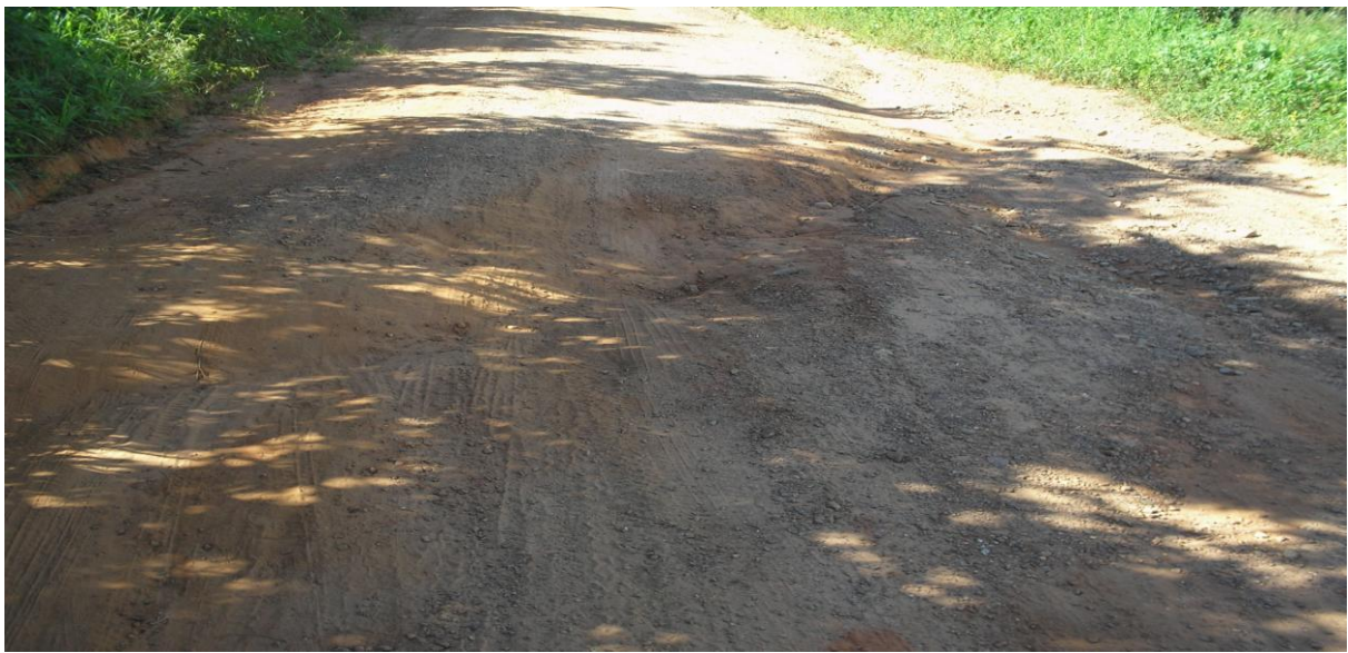
Figura 03: estrada dentro do assentamento Contagem Fonte: Trabalho de campo do autor. Brasília, 2012.
